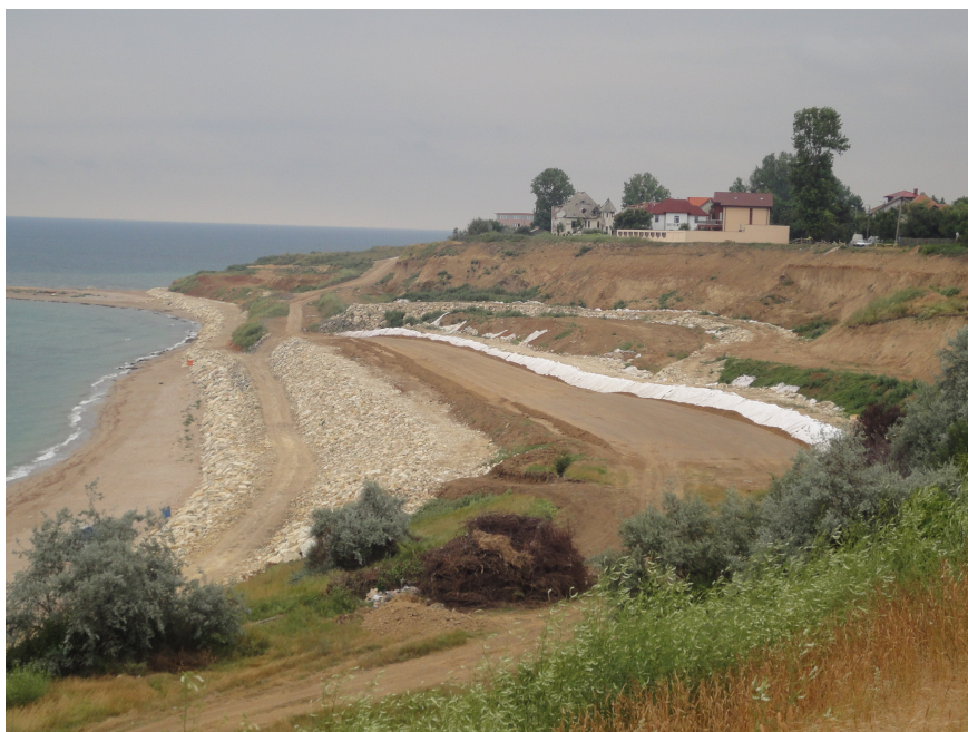
Figura 2.8.1 Lucrari de consolidare/stabilizare faleza in curs langa Eforie Sud
